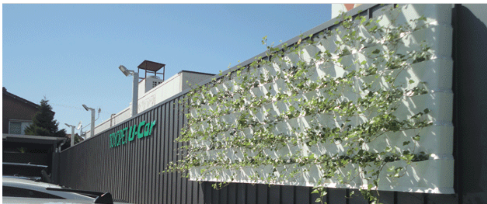
板垣をイメージさせる黒い立平葺きのスクリーン。プランター植物を取り付けて優しいアクセントに
