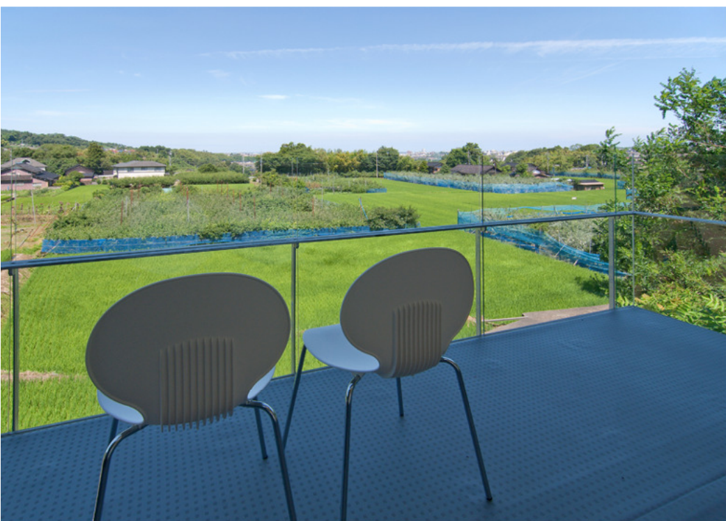
手摺り上部は片持ち強化ガラスで視界を良くしています。
