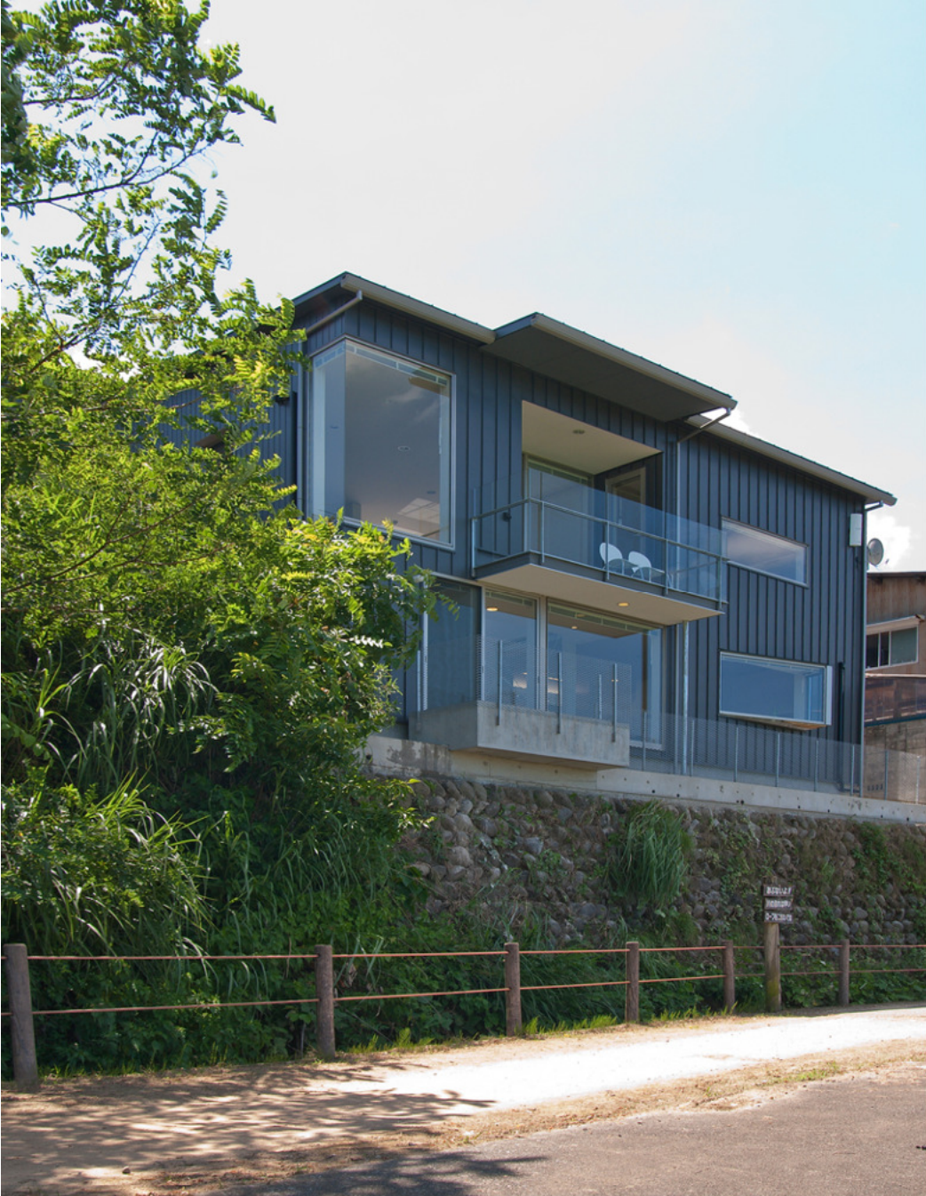
景観を考慮し、フェンスも亜鉛めっき仕上げのまま、色を抑えています。
