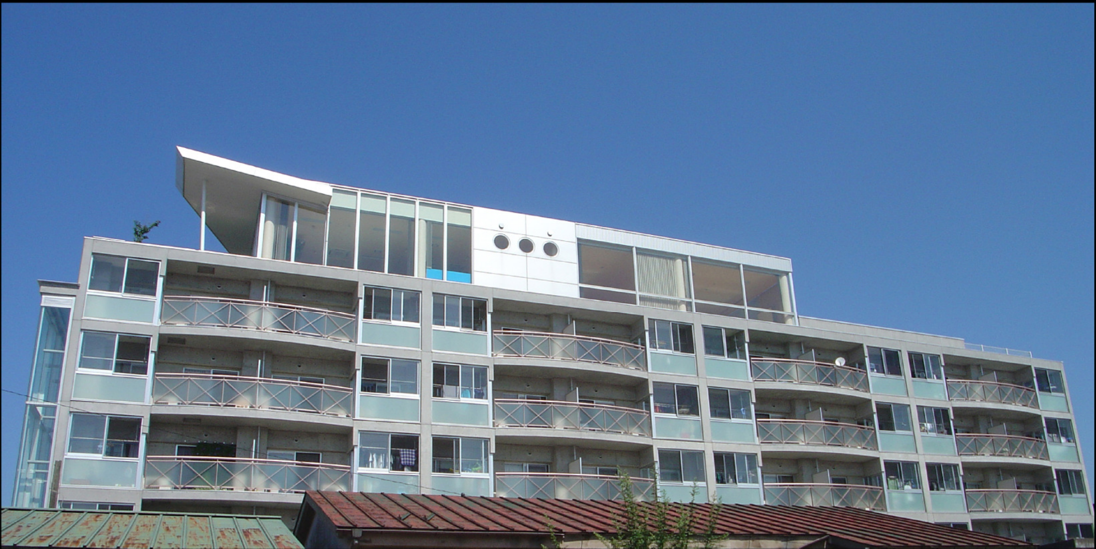
南道路からみた外観 — ガラスフェンスとガラスの多用により、RC打放し建物の重厚感の消去を意図しました。6階の上屋は鉄骨造で軽快感を意図しています。6階大庇裏はライトアップしています。
