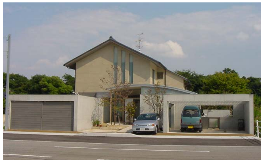
街並を考慮して瓦屋根に。
