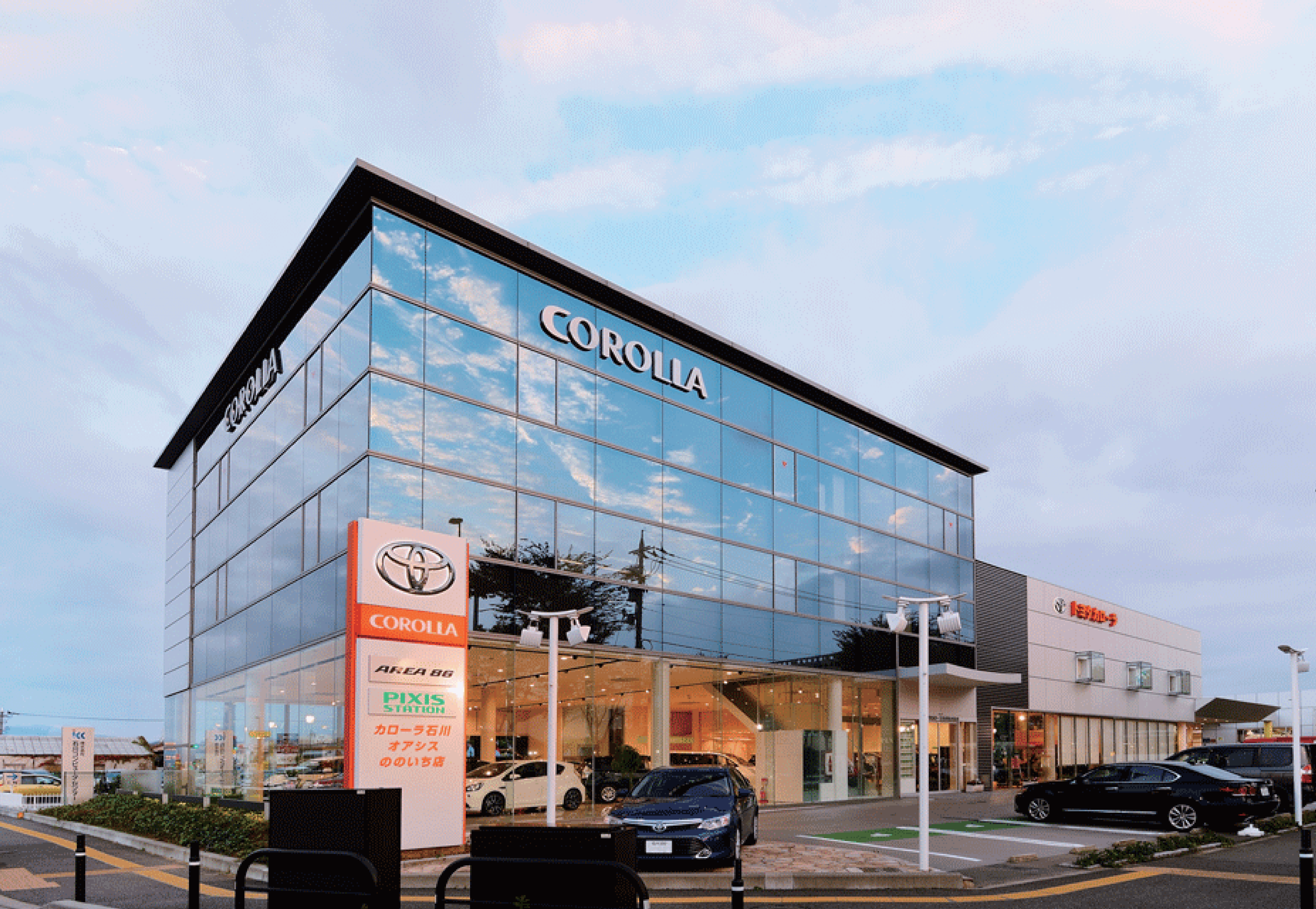
交差点に立地するので、外壁上部は熱線反射ガラスで空と街路樹を映すデザイン・1階は3方全面ガラスで透けた開放性のあるデザインとしています。
